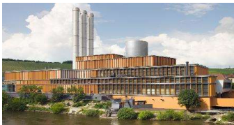
Strom- und Fernwärme- erzeugung; Strom-, FW-, Erdgas-Verteilung und -Vertrieb
